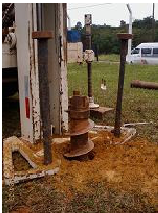
FIGURA 4.1 – INSTALAÇÃO DO REVESTIMENTO E FILTROS
