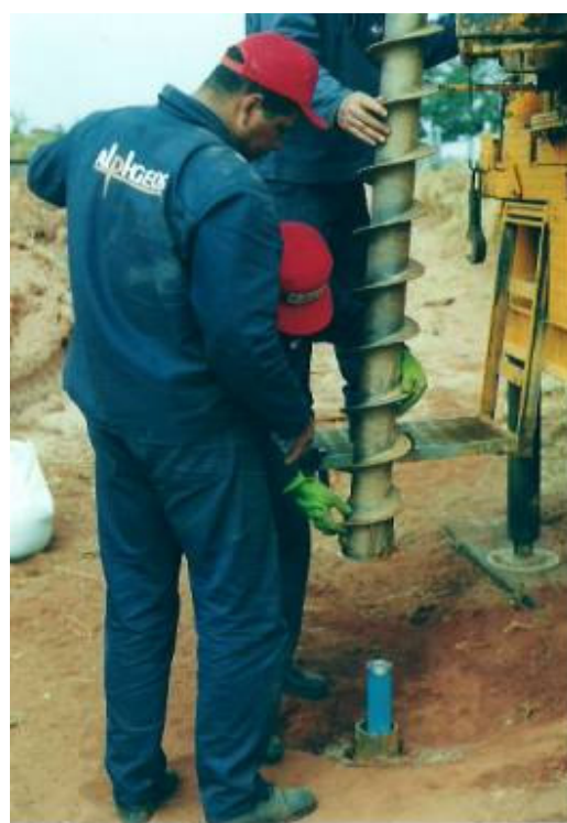
FIGURA 4.1 – INSTALAÇÃO DO REVESTIMENTO E FILTROS
