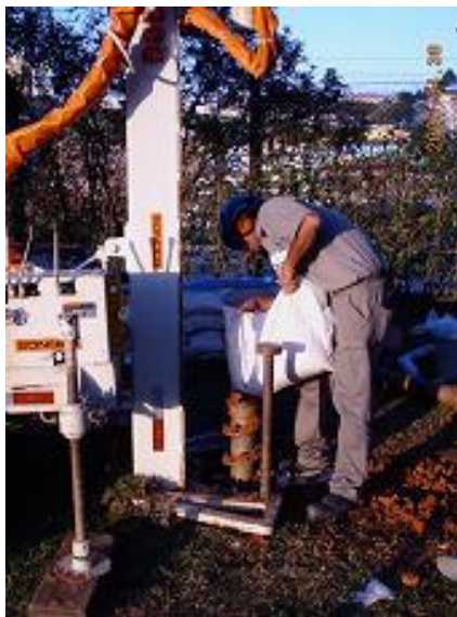
FIGURA 4.2 – INSTALAÇÃO DO ENVOLTÓRIO DE PRÉ-FILTRO
